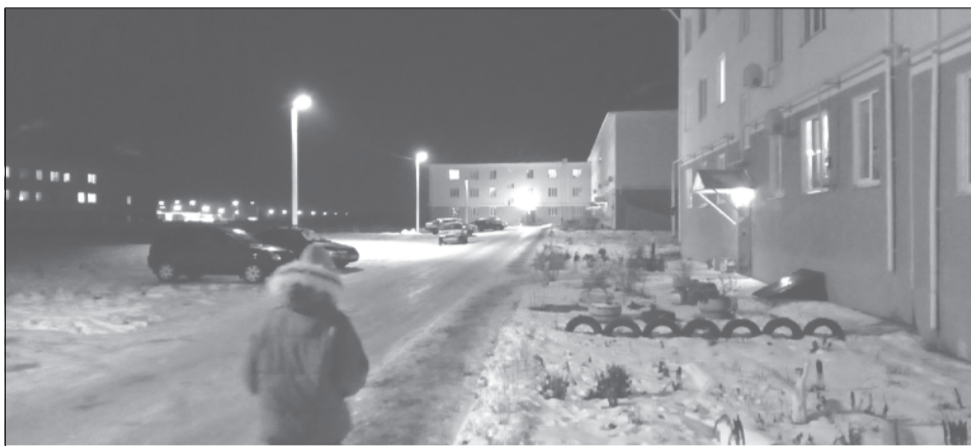
В микрорайоне Карачиха у новых домов по ул. Фурманова произведена работа по установке уличного освещения (19 опор, 36 светильников).
